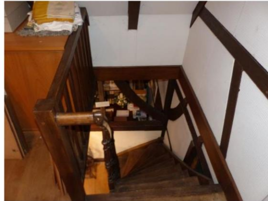
Dachbereich über Heimatstube
