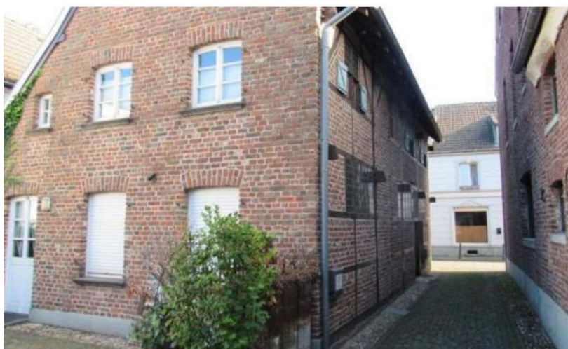
Rückwärtiger Gebäudeteil / Zugangssituation
